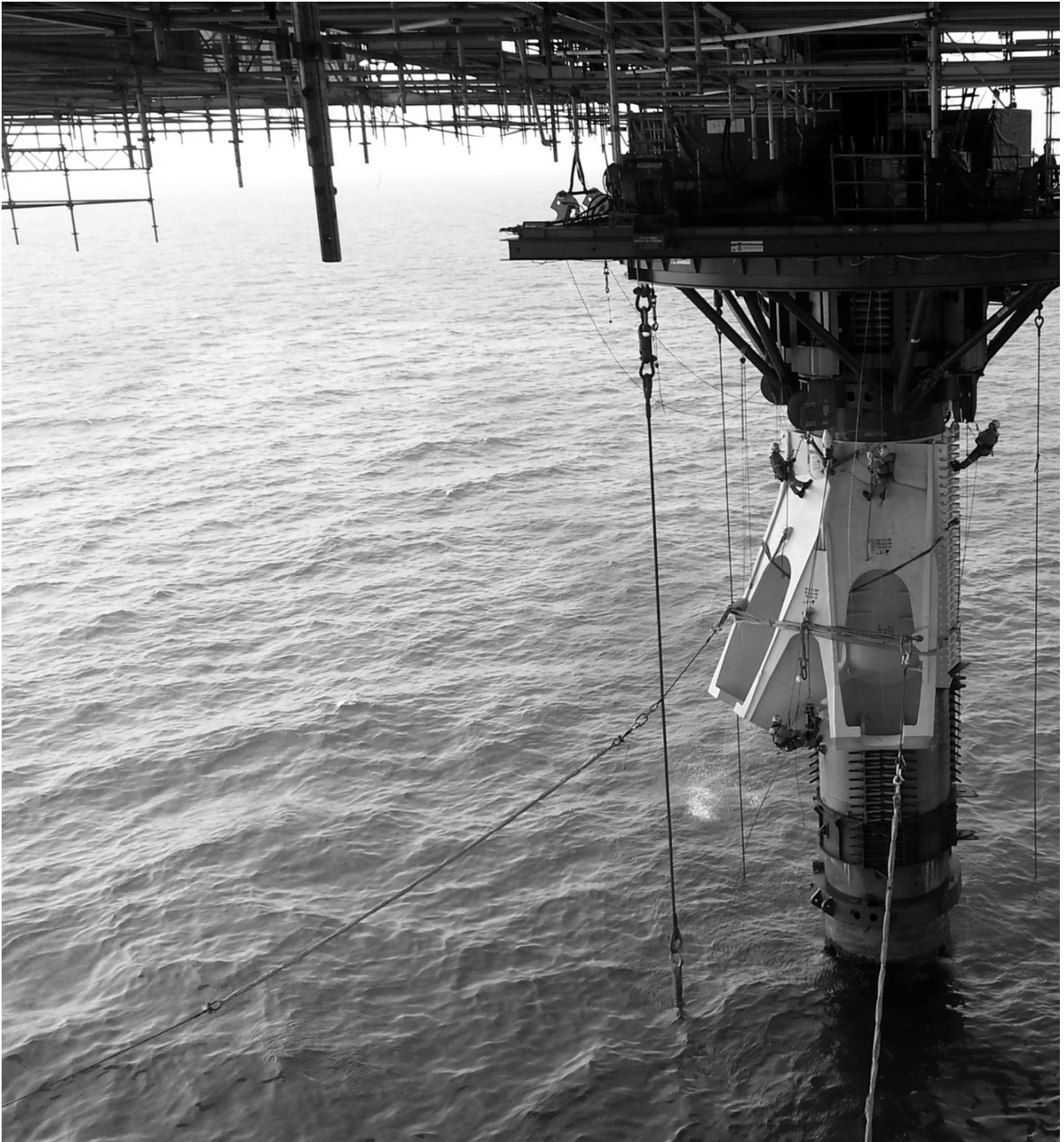
Forstærkning af undervandskonstruktionen på Siri platformen.
