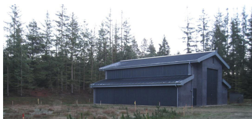
Eksempel på GIS-anlæg (Blåbjerg) udført som én lukket bygning indeholdende et gasisoleret kompakt indendørs koblingsanlæg samt en kompenseringsspole.
