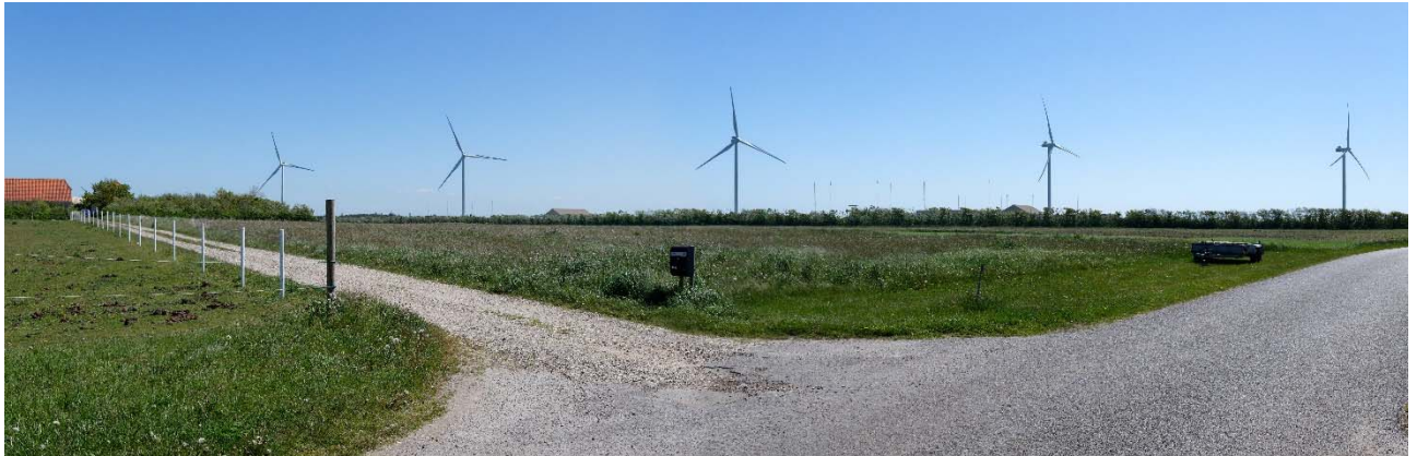
Figur 3-20: Fotostandpunkt 4 – Visualisering (med nye afskærmende beplantningsbælter). Fra Voldervej er synligheden af anlægget størst og kan opleves på korteste afstand. Anlæggets synlighed vil på sigt blive skærmet af de nye beplantningsbælter og vil ikke blive oplevet dominerende sammen med vindmøllerne. Det åbne landskabsrum indsnævres med anlægget og de nye beplantningsbælter.
