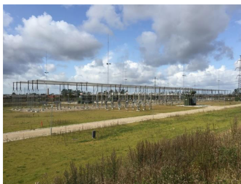
Eksempel på AIS-anlæg (Bjæverskov).
