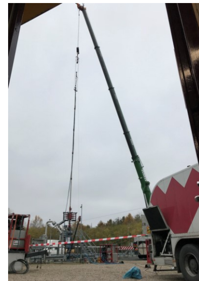
Årlig gasmåling i brønd.
