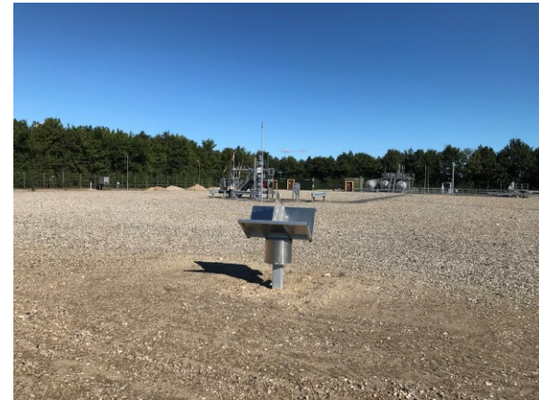
Udsigt over brøndplads ved Stenlille Gaslager
