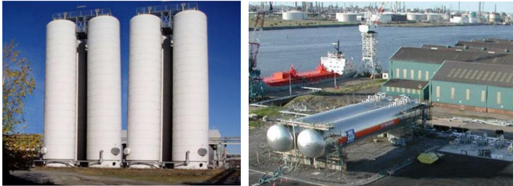
Figur 3-7 Eksempler på mindre lagertanke til opbevaring af CO 2 [6].
