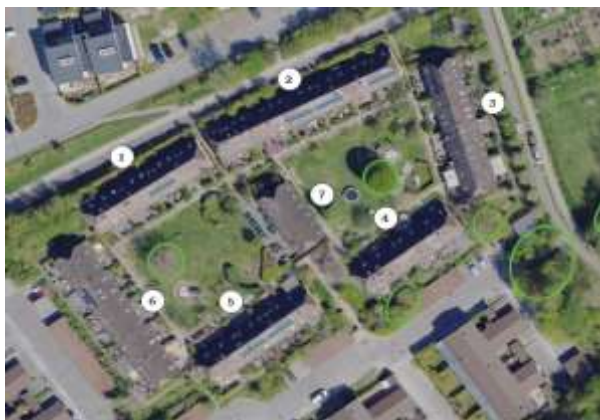
Foto: Oversigt over bygninger i Stavnsbåndet. Længehuse nr. 1-6. Fælleshus nr. 7.
