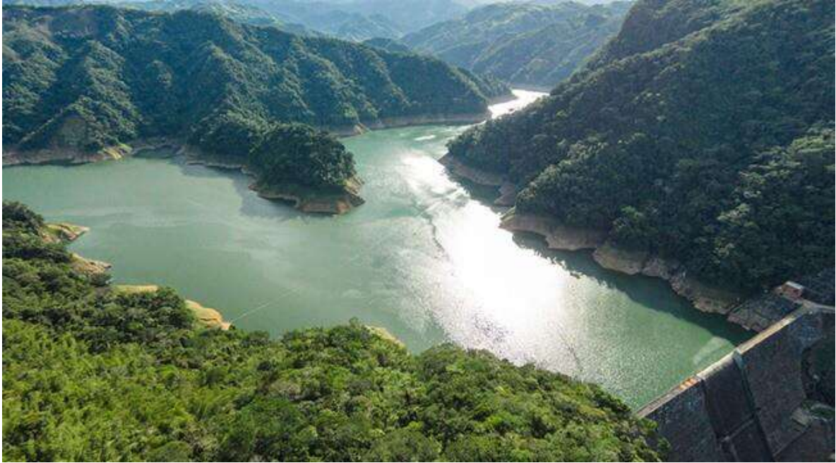
Figura 50. Proyecto Hidroeléctrico Miel I [21].
