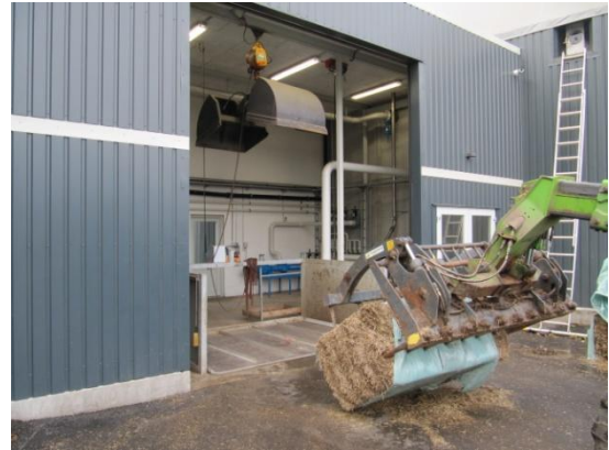
Billede 31: Dosering i fortank med teleskoplæsser
