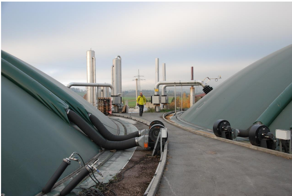
Stort tysk anlæg på 4 MW, hvor der bruges fast biomasse (ingen gylle) og opgraderes biogas til naturgaskvalitet.
