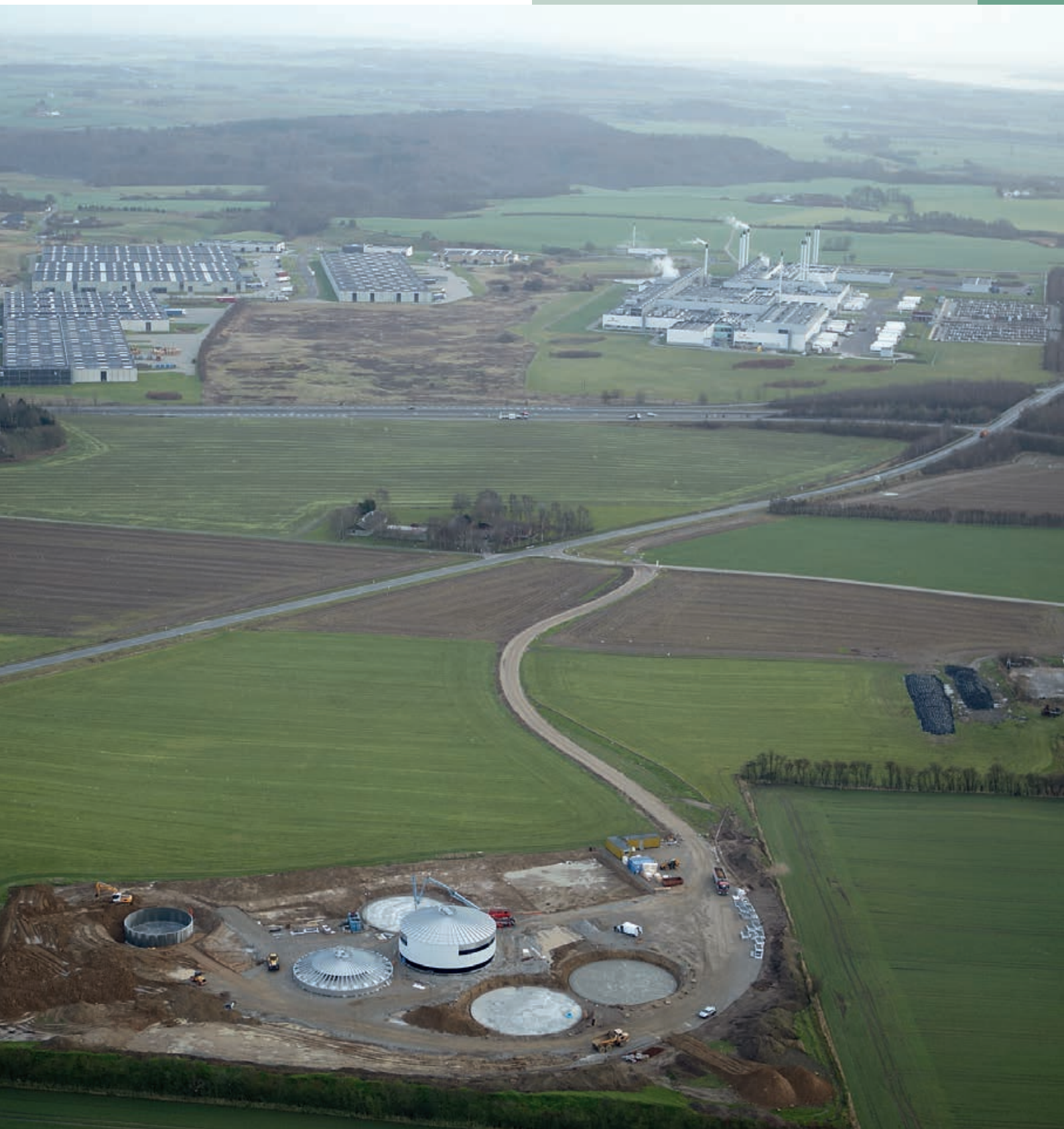
Horsens Bioenergi under opførsel ultimo 2013
