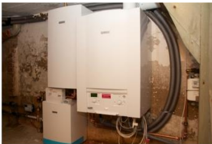
Figur 3. Hybridløsning i Stenderup, hvor en mindre varmepumpe supplerer en almindelig gaskedel.
