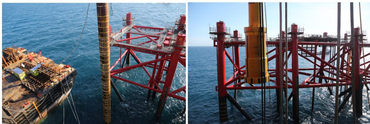
Figur 2-4 Pæl (venstre) og hammer til nedramning (højre)
