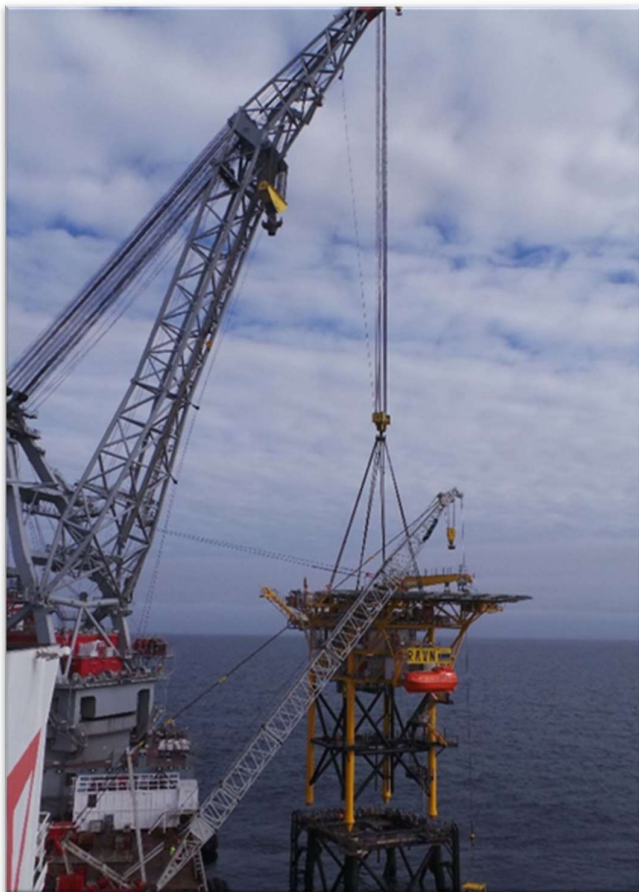
Figur 6-13 Løft af topside (eksempel fra opførelse).
