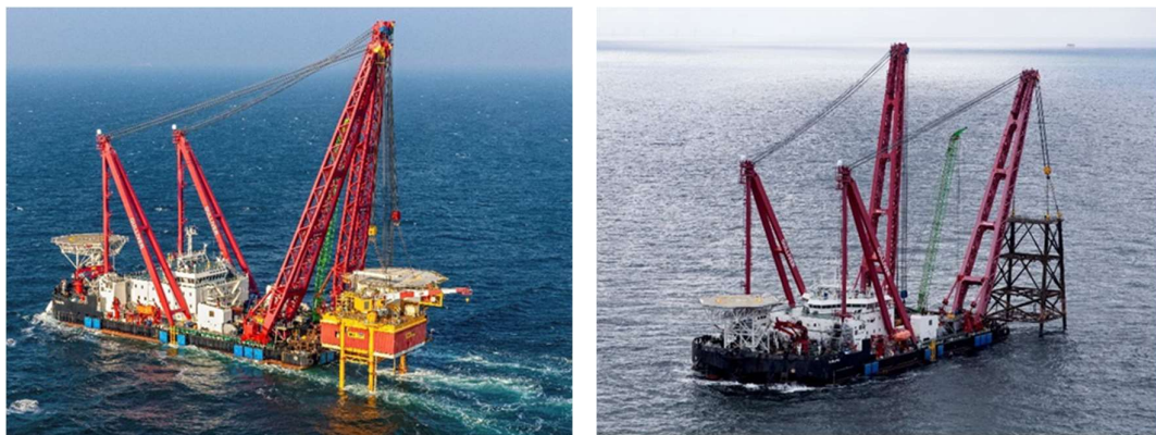
Figur 6-17 Eksempel på transport af topside og jacket i kran krog.
