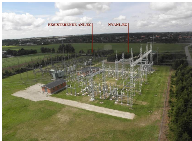
FIGUR 9 EKSEMPEL PÅ UDVIDELSE AF EKSISTERENDE STATIONSANLÆG (BREDEBRO UDENDØRS STATIONSANLÆG, 150 KV).
