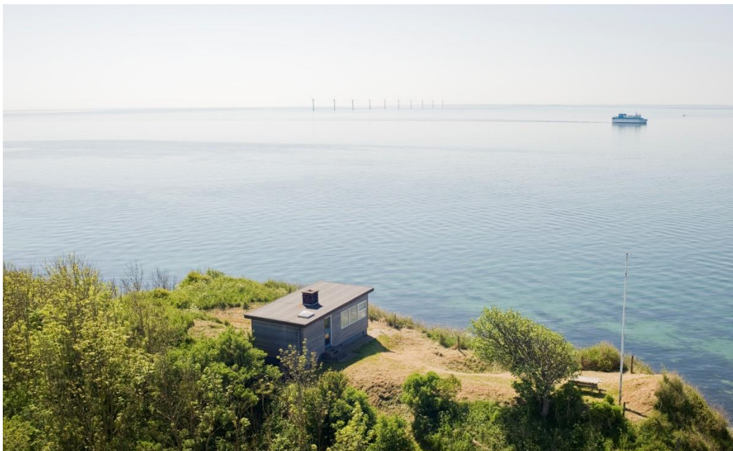
FIGUR 2 EKSISTERENDE KYSTNÆR VINDMØLLEPARK - SYD FOR SAMSØ. DE 10 MØLLER PÅ HVER CA. 103 METER TOTALHØJDE HAR TILSAMMEN EN INSTALLERET EFFEKT PÅ 23 MW OG BEFINDER SIG OMTRENT 4,3 KM FRA KYSTEN PÅ FOTOET.
