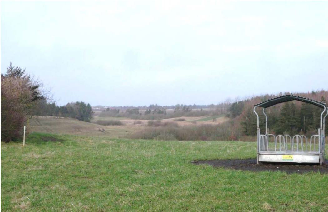
Figur 7-8. Udsigt gennem Glarbjerg Bæk ådal fra Døjvej. Stationsanlægget vil ligge bag træerne i højre side af billedet, men masterne forventes at være synlige.
