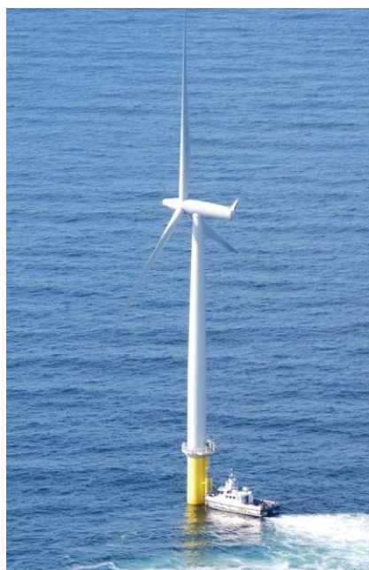
FIGUR 4 ILLUSTRATION AF GRÅ HAVMØLLE MED GUL MARKERING PÅ DEN NEDERSTE DEL AF MØLLETÅRNET.
