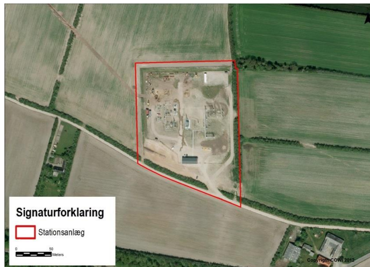
FIGUR 11 LUFTFOTO AF DET EKSISTERENDE STATIONSAREAL VED LEM KÆR, DER ER MU- LIGHED FOR AT SKULLE UDVIDE I FORBINDELSE MED PROJEKTET.
