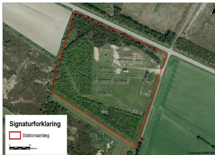
FIGUR 12 LUFTFOTO AF DET EKSISTERENDE STATIONSAREAL VED STOUSTRUP, DER ER MULIGHED FOR AT SKULLE UDVIDES I FORBINDELSE MED PROJEKTET.
