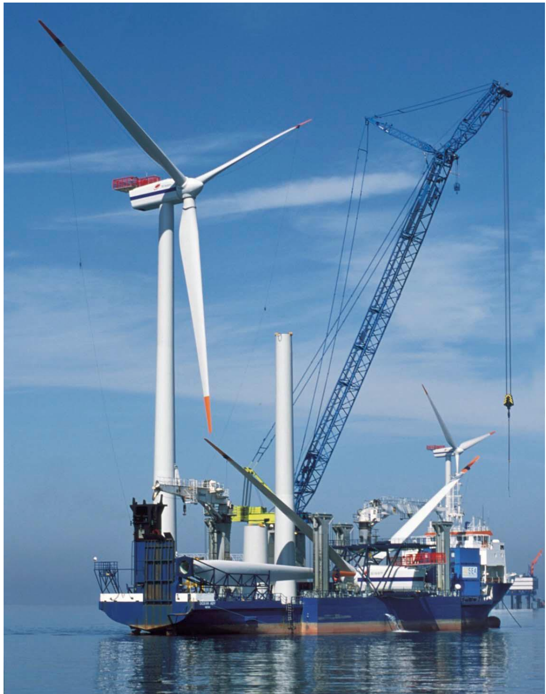
Montering af havmøller – Horns Rev 1 (Foto: Energinet.dk).
