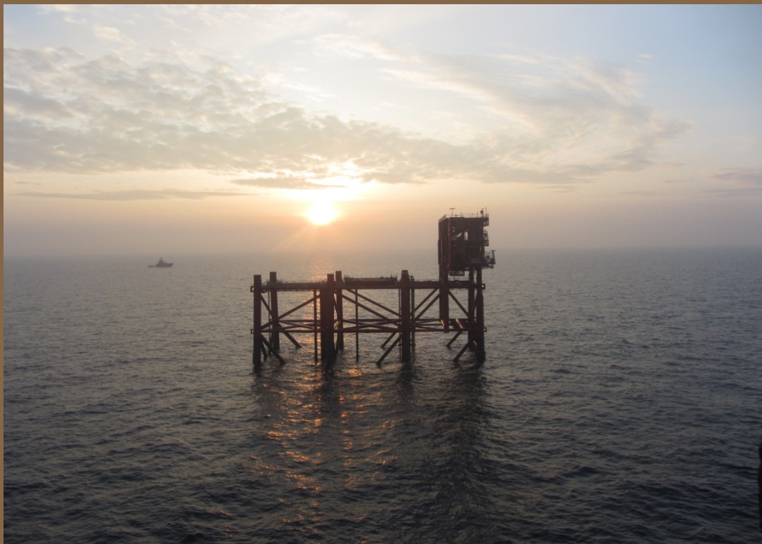
Jacket med brøndhovedmodul på Hejre feltet, juni 2014.
