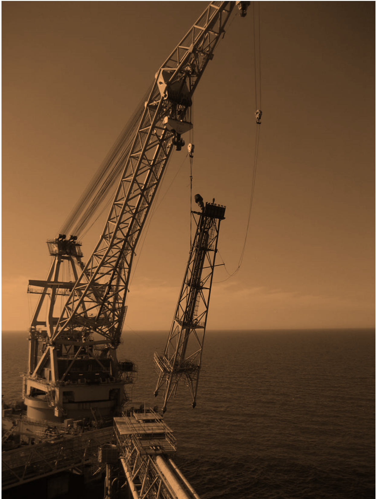
Udskiftning af flaretårn på Tyre vest platformen. Foto: Stig Busk Jespersen
